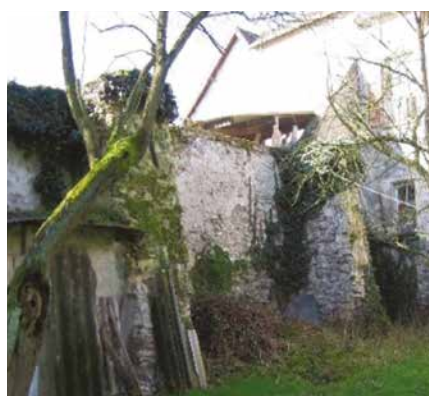
Les contreforts de l'église de Souilly (photo de 2007)
