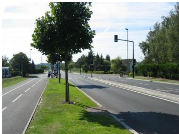
RD34 en agglomération au niveau du lycée
